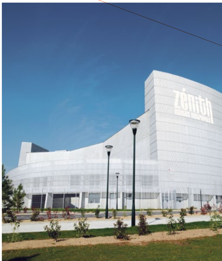
ZENITH DE 44 NANTES - FRANCE (Atelier d' Architecture Chaix & Morel et associés)
